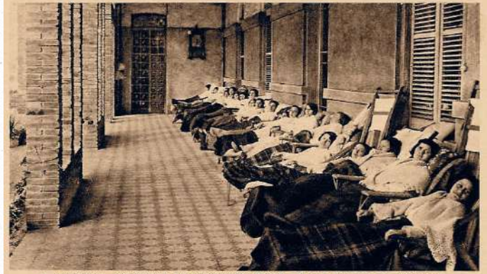
9. HOSPITAL-SANATORI DE L'ESPERIT SANT - SANTA COLOMA DE GRAMANET Pavelló de dones. Galeria de cura
