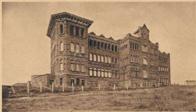
2. HOSPITAL-SANATORI DE L'ESPERIT SANT - SANTA COLOMA DE GRAMANET Pavelló d'homes en construcció
